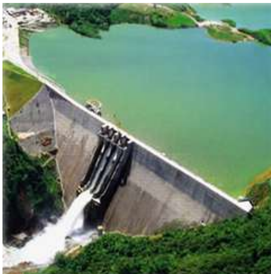
Foto 52. Central hidroeléctrica Porce II.
