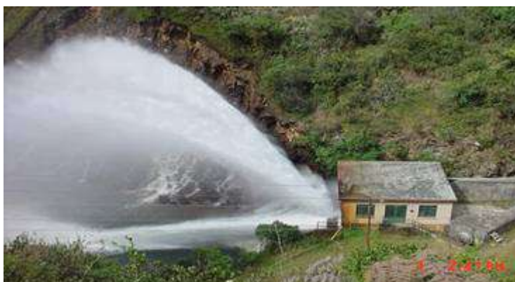
Foto 43. Panorámica de la casa de máquinas del embalse del Sisga, con la válvula descargando 3.0 m 3 /s.
