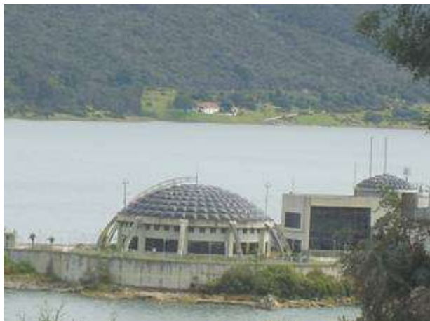
Foto 46. Estación de bombeo del embalse de San Rafael.
