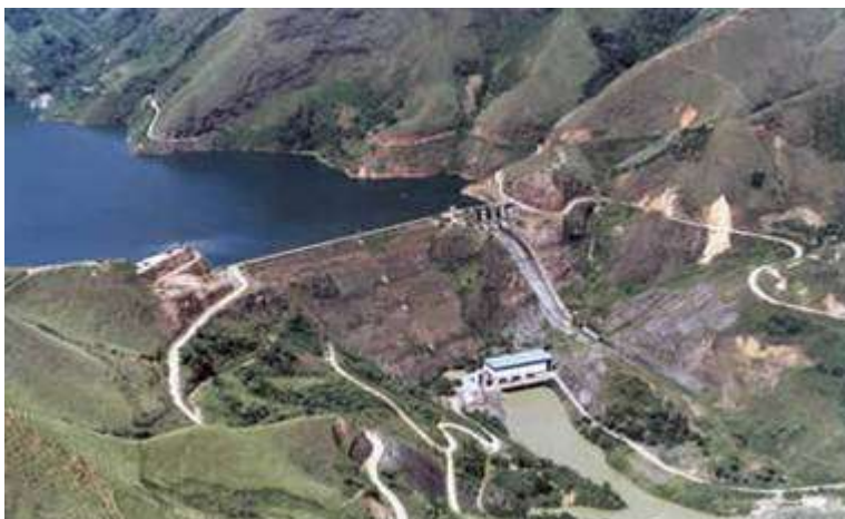
Foto 55. Central hidroeléctrica Salvajina.
