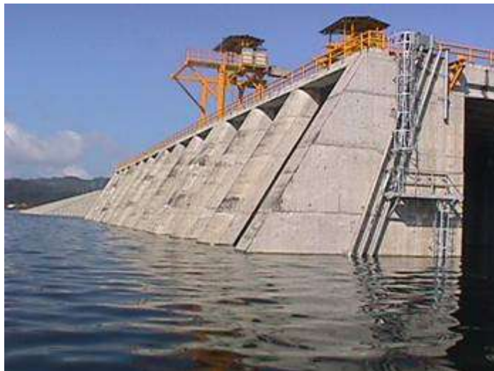
Foto 56. Central hidroeléctrica Urrá I.
