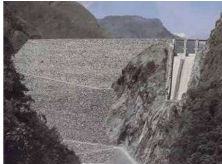
Foto 54. Central hidroeléctrica Chivor.
