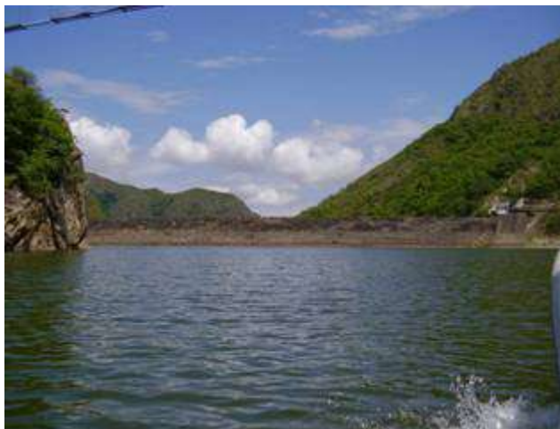
Foto 60. central hidroeléctrica embalse de Prado.
