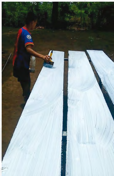
FIGURA 97 a. Aplicación de hule líquido sobre el tablón.
