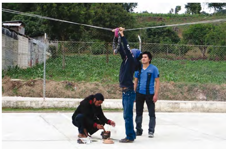
FIGURA 46. Instalación del aro de madera en el centro del campo de baloncesto.
